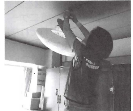
照明器具のカバーの交換
